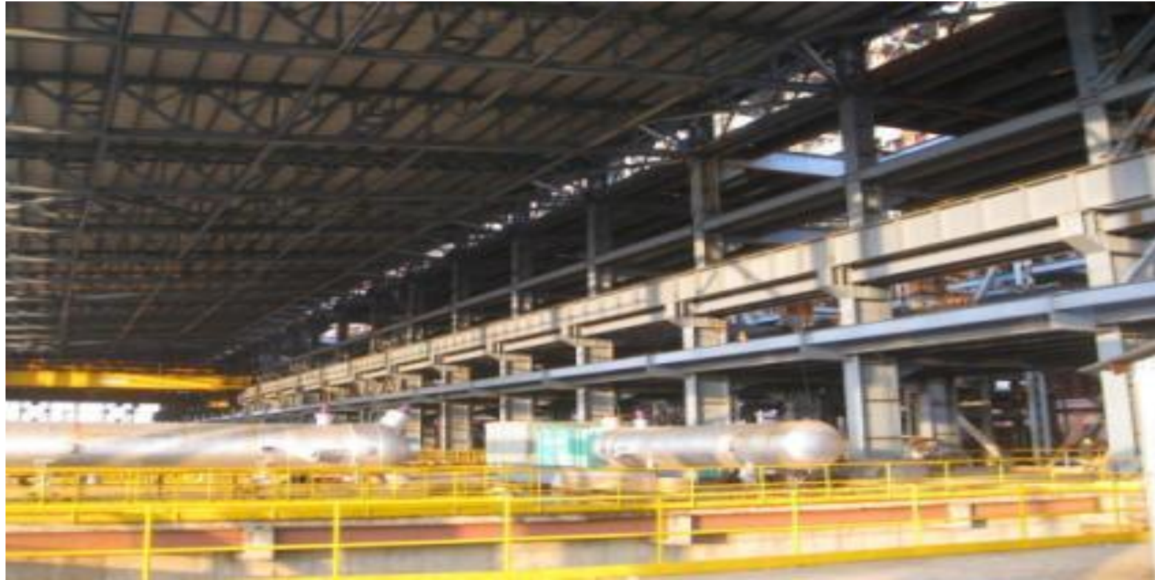
THYSSENKRUPP (TKIL) OBRA POWER PROJECT
